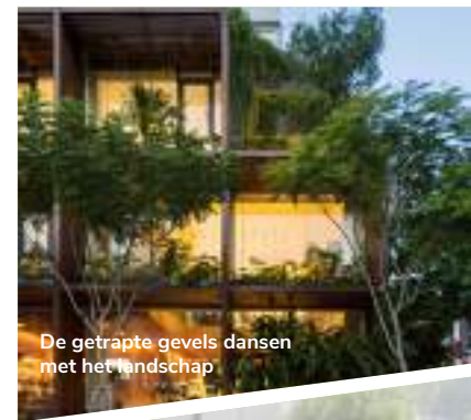
Een gebouw als een terrassen landschap met pergola's en dakterrassen op zuid-west georiënteerd Ruimte voor groen en waterberging opgenomen in de architectuur
