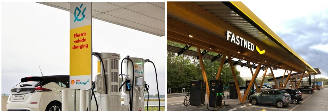
Figuur 9: Ultrasnelladen >150 kW.
