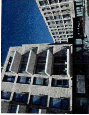
BUITENRUIMTE AAN GEBOUW, LICHTE AARDESE TINTEN
