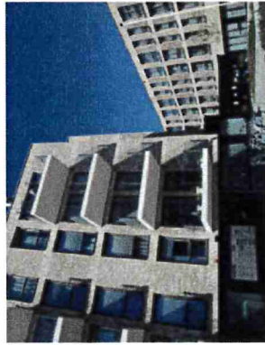
BUITENRUIMTE AAN GEBOUW, LICHTE AARDESE TINTEN
