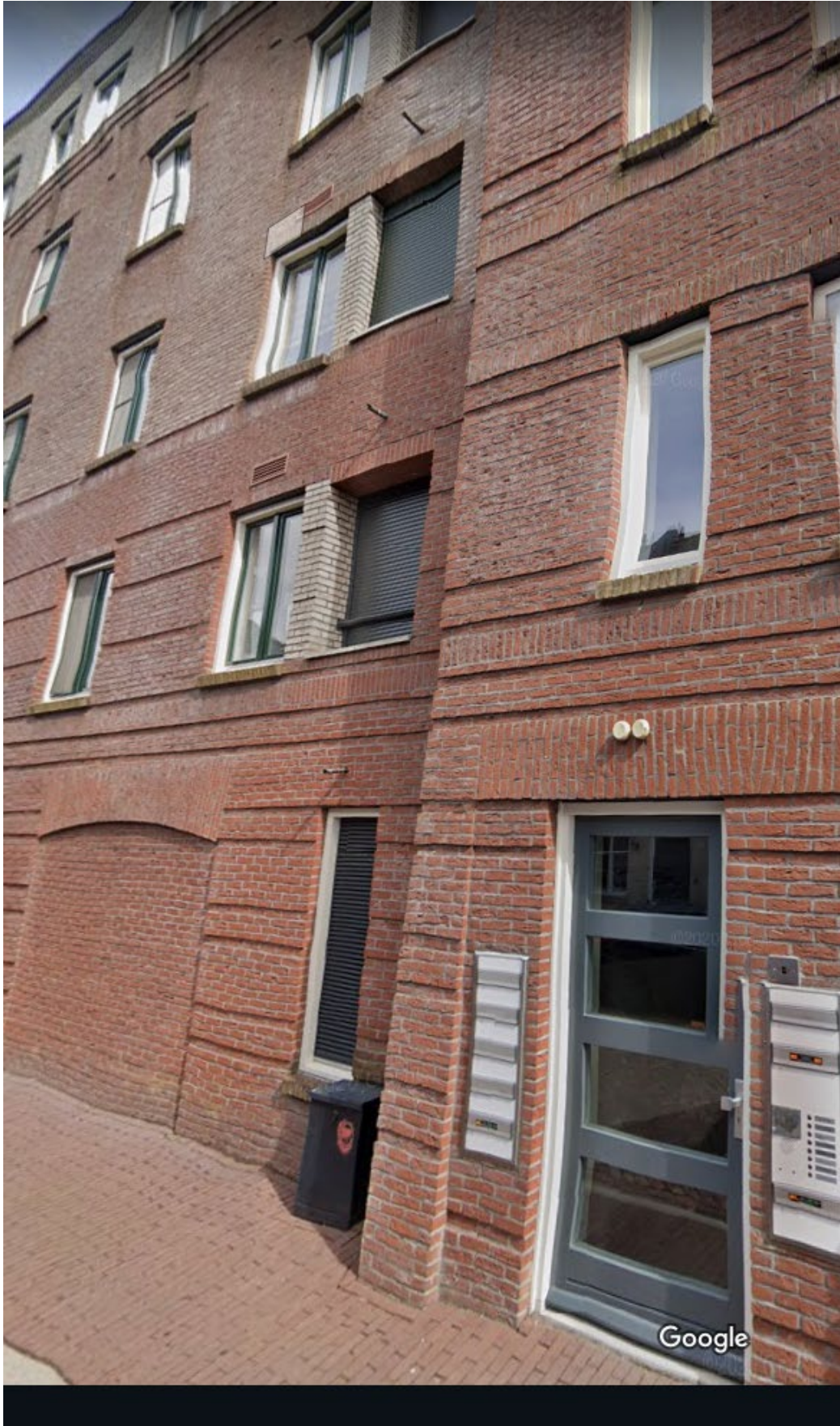
Weverskwartier. rolluiken geplaatst voor extra beschermde vluchtroute.
